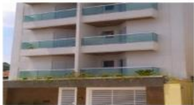
Construções de Prédios
