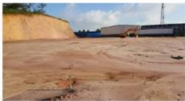
Serviços de Terraplenagem
