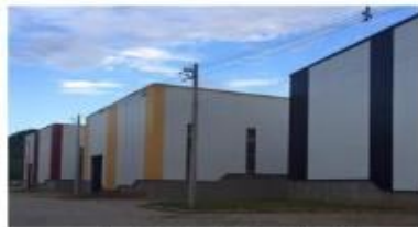
Construção de Galpões Industriais
